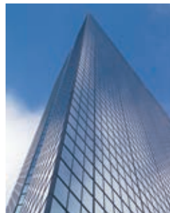
HLK / Gebäude- management
