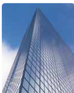
HVAC / ビル管理
